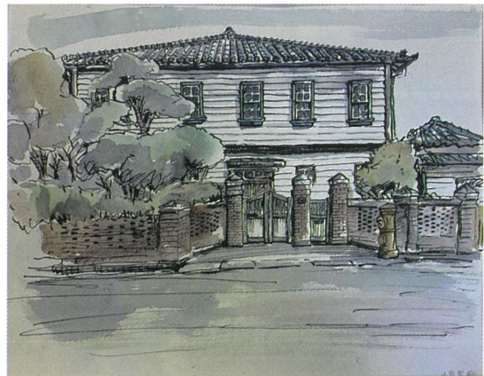
図⑨ 小泉製麻(旧本社)
