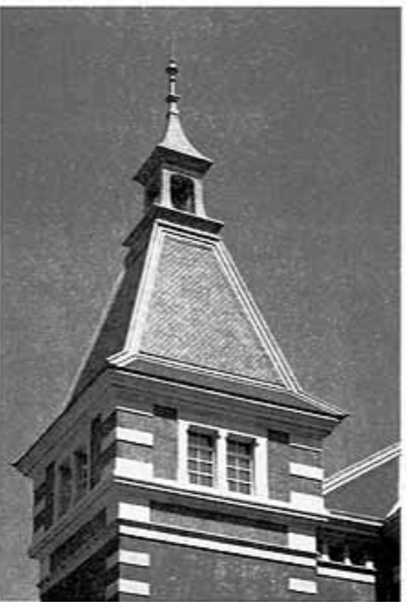
写真九 尖塔部
